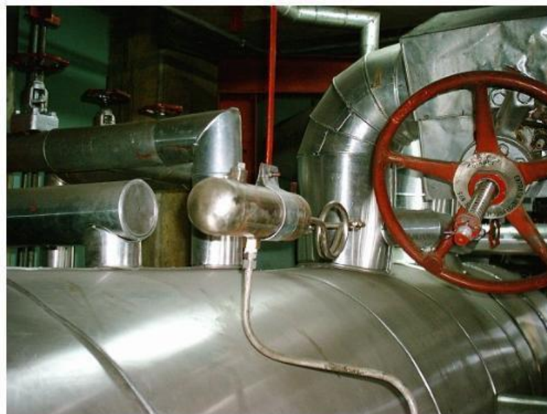
R4 , R5 UNIDAD3 TERMOPAIPA
